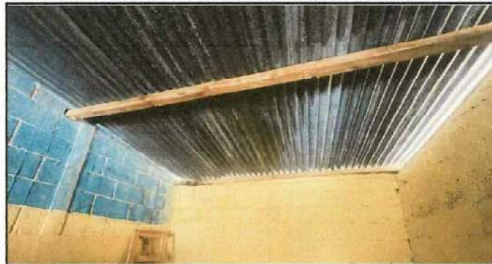
Foto 2: Instalación de lamina troquelada y estructura de metal para mayor durabilidad en area de bodega. Así mismo levantamiento de block para nivelación de altura.
