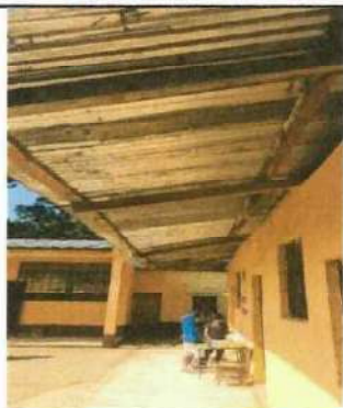
Foto 7: Mejoramiento de cubierta de lamina y estructura de metal en area de salón y cocina.
