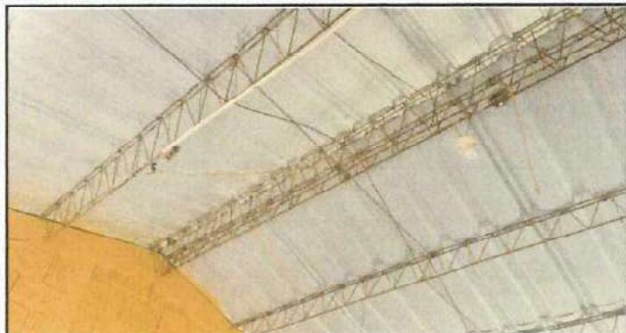
Foto 1: Mejoramiento de cubierta de lamina en mal estado por lamina troquelada, así mismo instalación de estructura de metal en aula y bodega.
