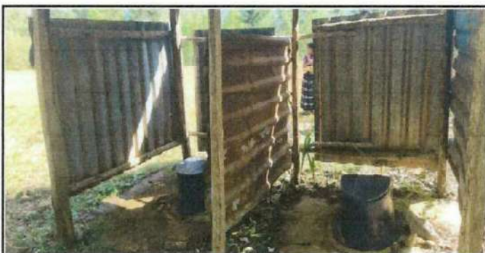
Foto 11: Sustitución de letrinas en mal estado, e instalación de tasas formales con todo y accesorios para los servicios sanitarios.
