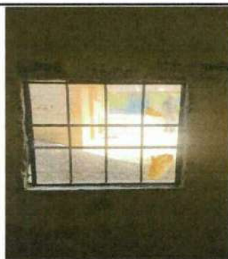
Foto 3: Instalación de ventana pvc en bodega, debido al deterioro y mal estado de la actual.
