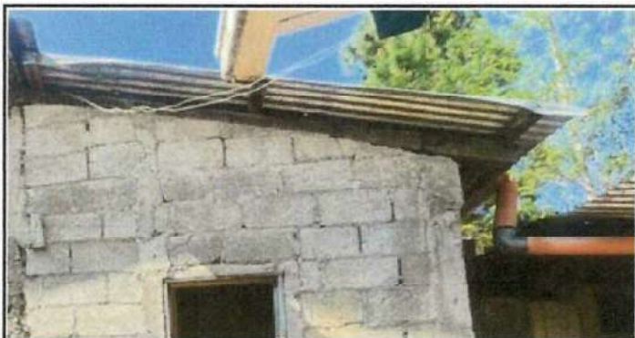
Foto 9: Mejoramiento de sistema electrico principal en aula, bodega, salon y cocina.
