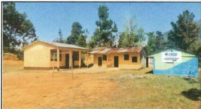
Foto 13: Pintura en interior y exterior de paredes de aula, bodega y salón mejorando las condiciones actuales del establecimiento educativo.
