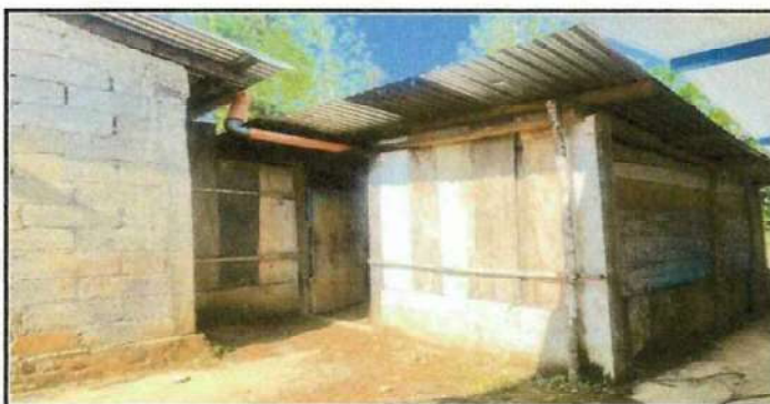
Foto 12: Mejoramiento de pared de madera por block y malla para area de cocina.
