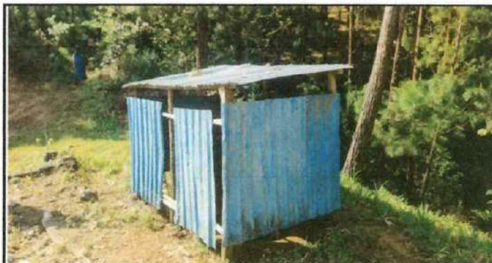
Foto 10: Mejoramiento de pared de lamina y estructura metalica debido al deterioro de la actual, asi mismo ampliación de servicios sanitarios debido a la falta de dicho servicio basico.
