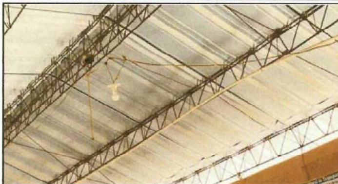
Foto 8: Mejoramiento de sistema electrico principal en aula, bodega, salon y cocina.
